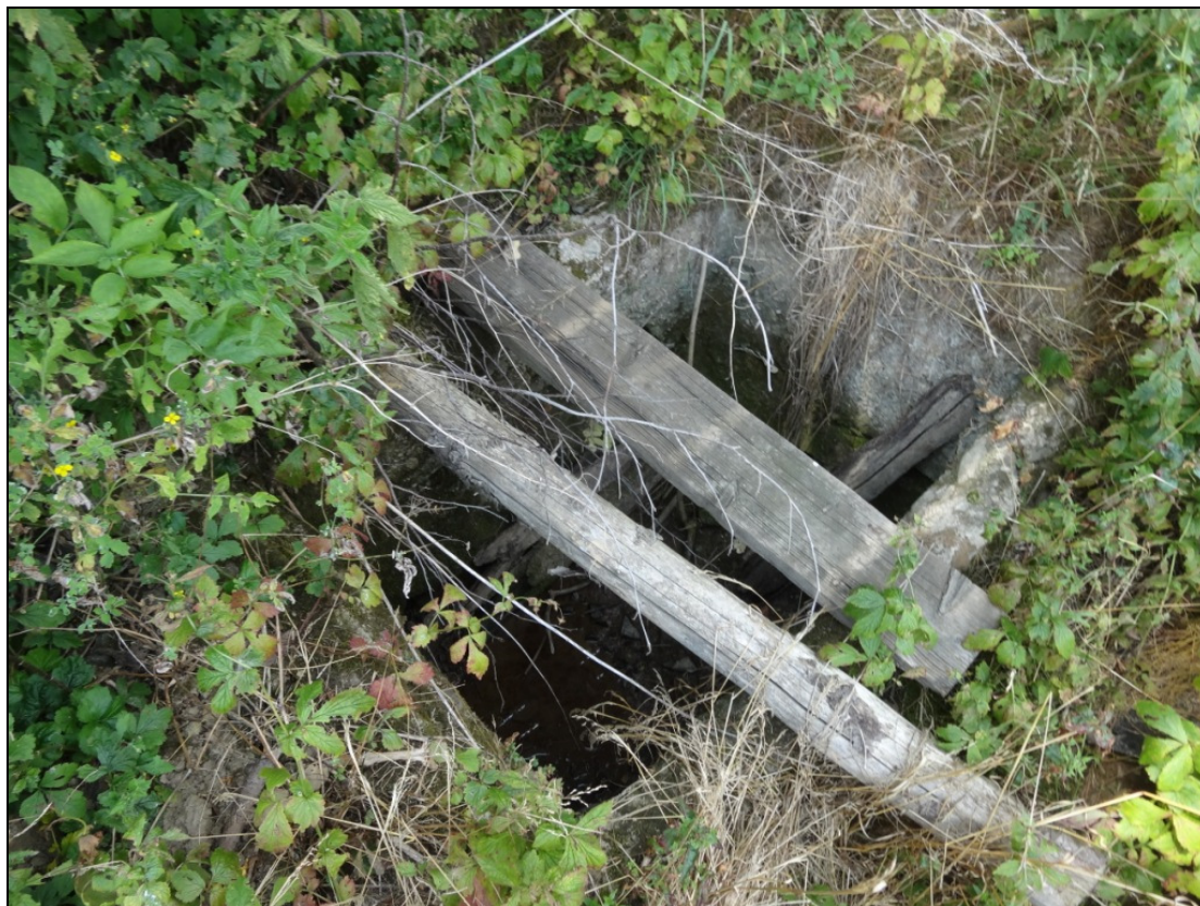
Obr. 12: Nezabezpečená jímka v těsné blízkosti mostu v km 39,829
